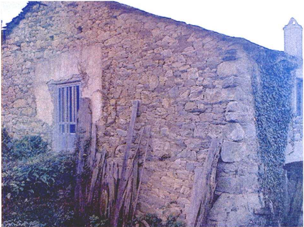
Fig. 4 . VIVIENDA DEL PUEBLO DE ALBAREDO CONSTRUIDA CON CUARCITAS Y ARENISCAS PERTENECIENTES A LA CUARCITA SUPERIOR DEL RÍO EÓ.
