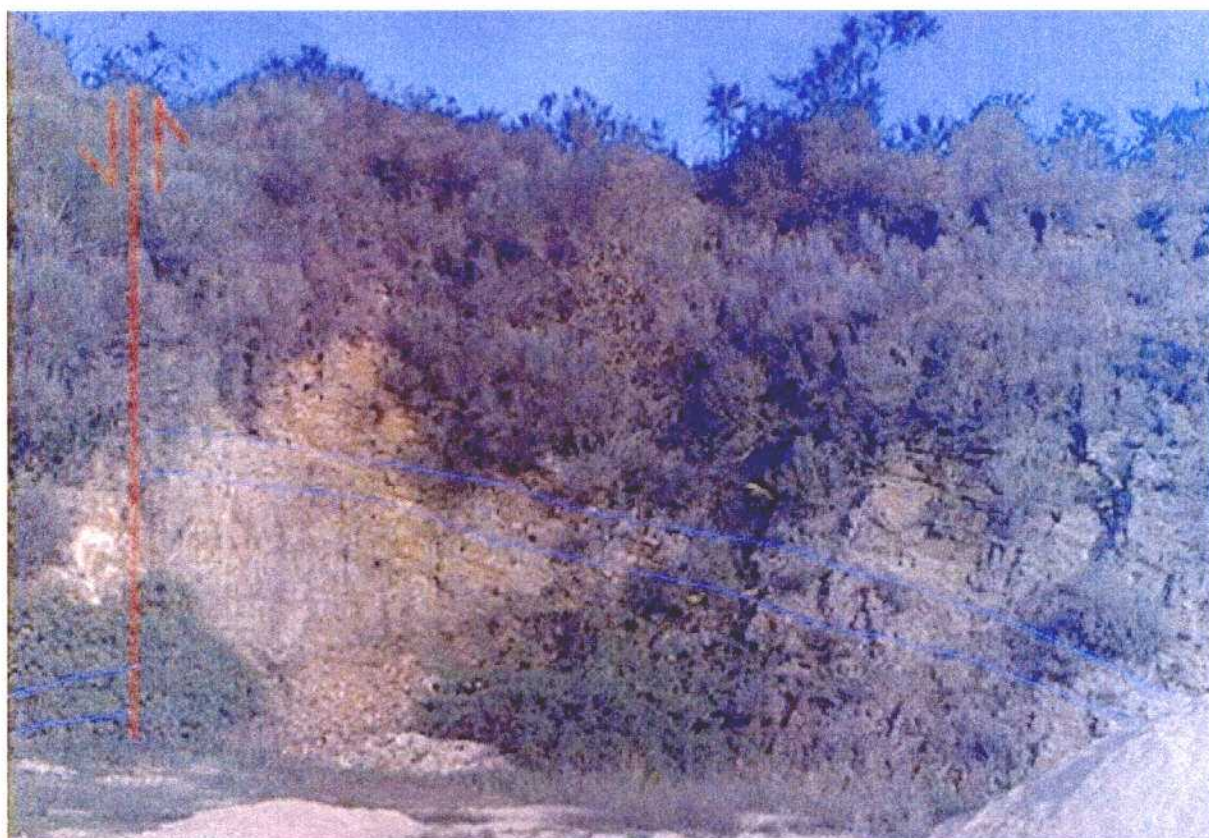
Fig. 8 FALLA EN LA ESTACIÓN 124004.
